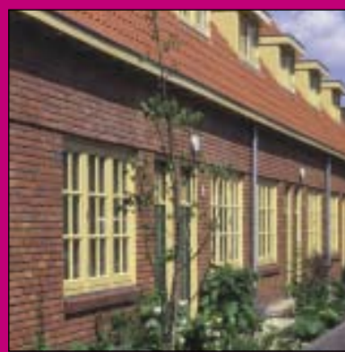
De Spreeuwenstraat na de renovatie
