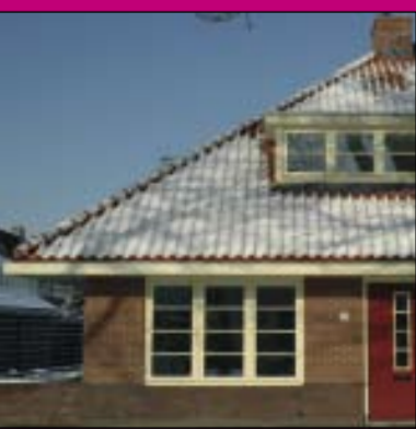
Nieuwbouw aan het Van 't Hoffplein
